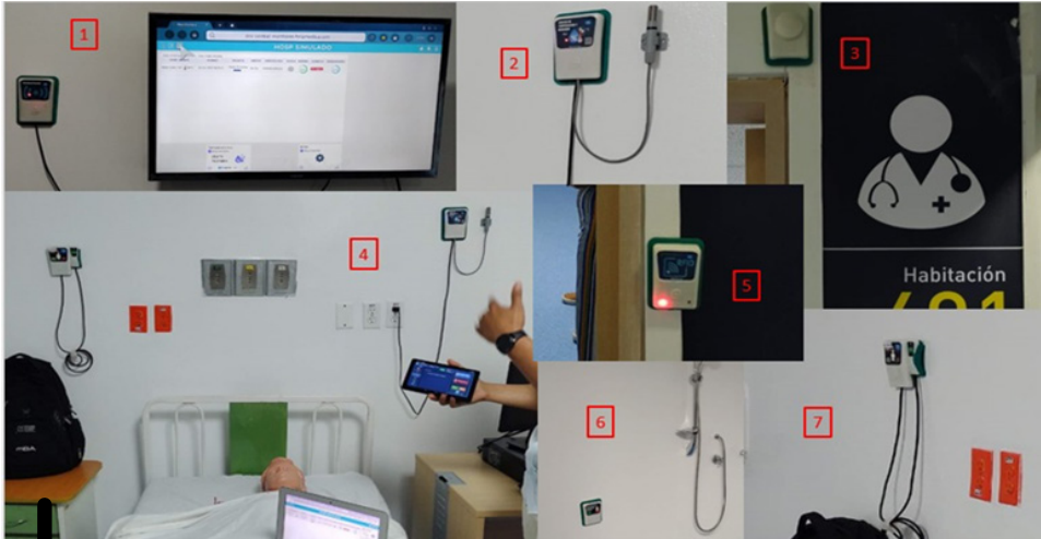
Figura 14. Instalación del sistema SIAP.
